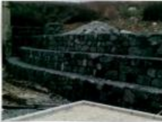
Gablon Duvar İmalatları
