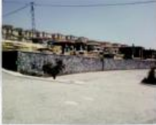
Taş Duvar İmalatları
